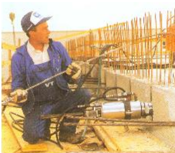
Mit einer Presse werden die Spannkabel gespannt
