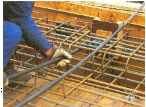
Einbau des Spannankers zwischen der schlaffen Bew.
